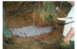
Figura 2: Foto mostrando nascente protegida, antes do selamento com solo cimento.
